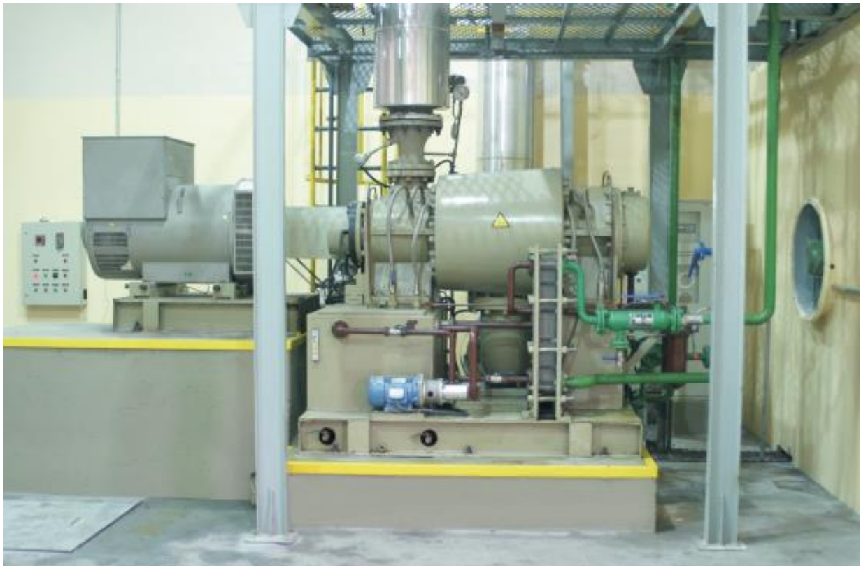
Figura 5: Parafuso helicoidal montado. (3)
