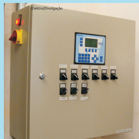
Sistema desliga bombas no horário de ponta
